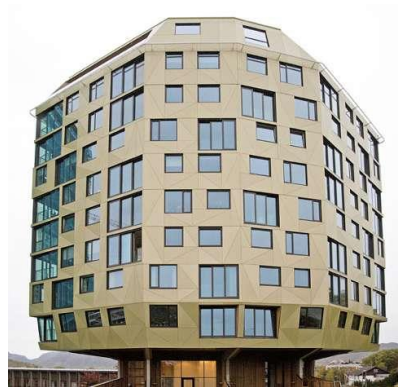
Blokk som består av 33 selveierleiligheter på mellom 72 og 215m 2 .
